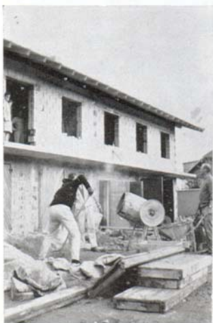
Bau der Bundeslehrstätte Seeham September 1966
