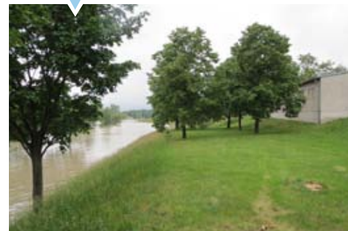
Hochwasser beim ABZ
